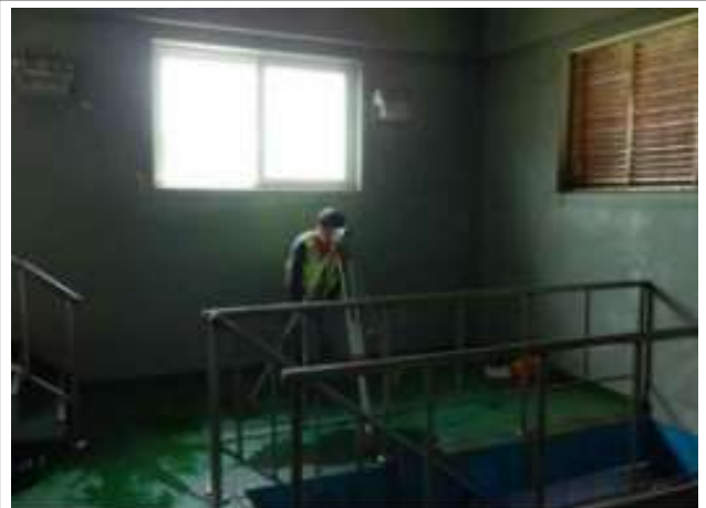
건축물 변위·변형 측정
