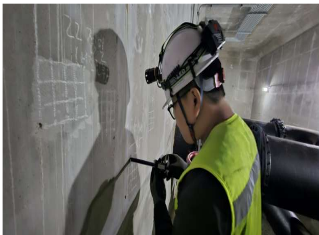
탄산화 깊이 측정
