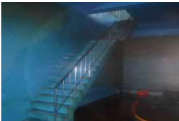
배수지 내부 안전난간 상태양호
